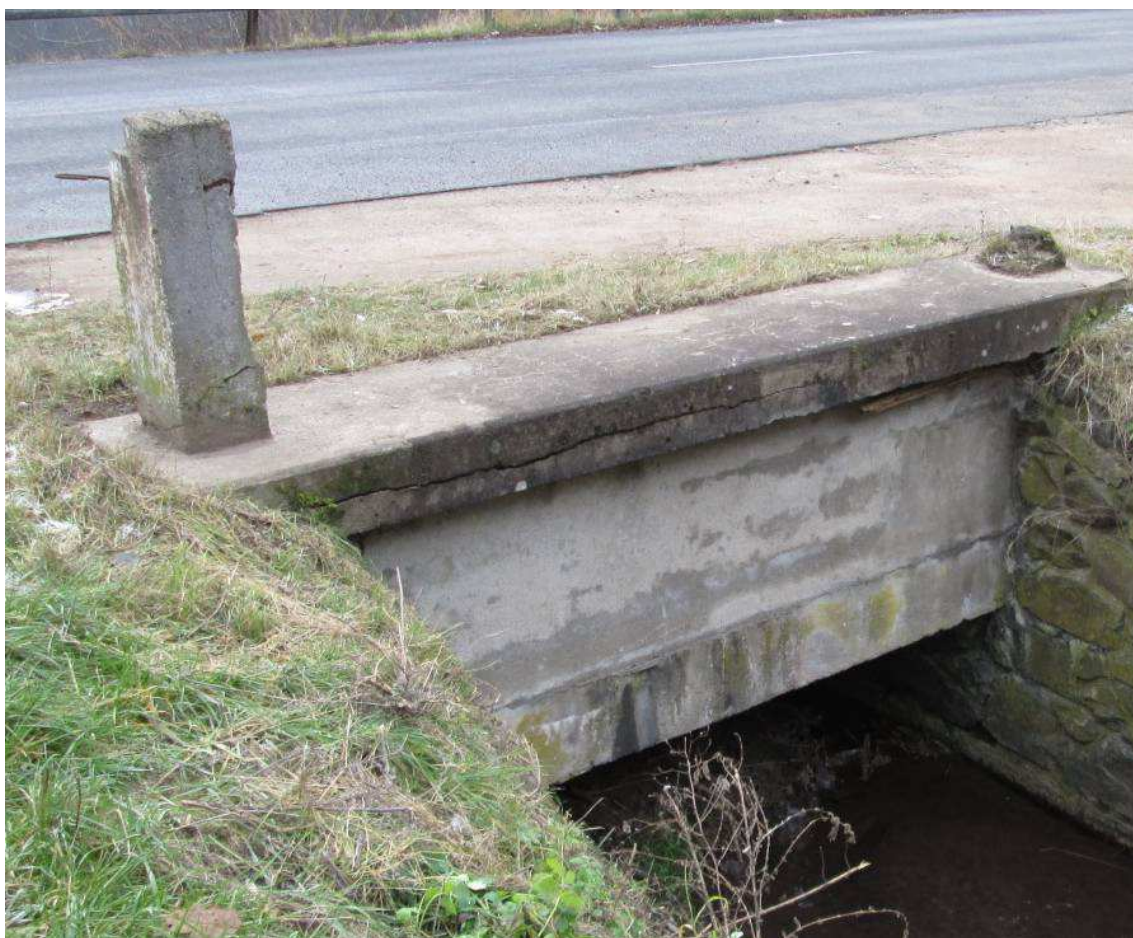
Pravý bok. NK – trhliny, výluhy. Římša – vodorovná trhlina.
