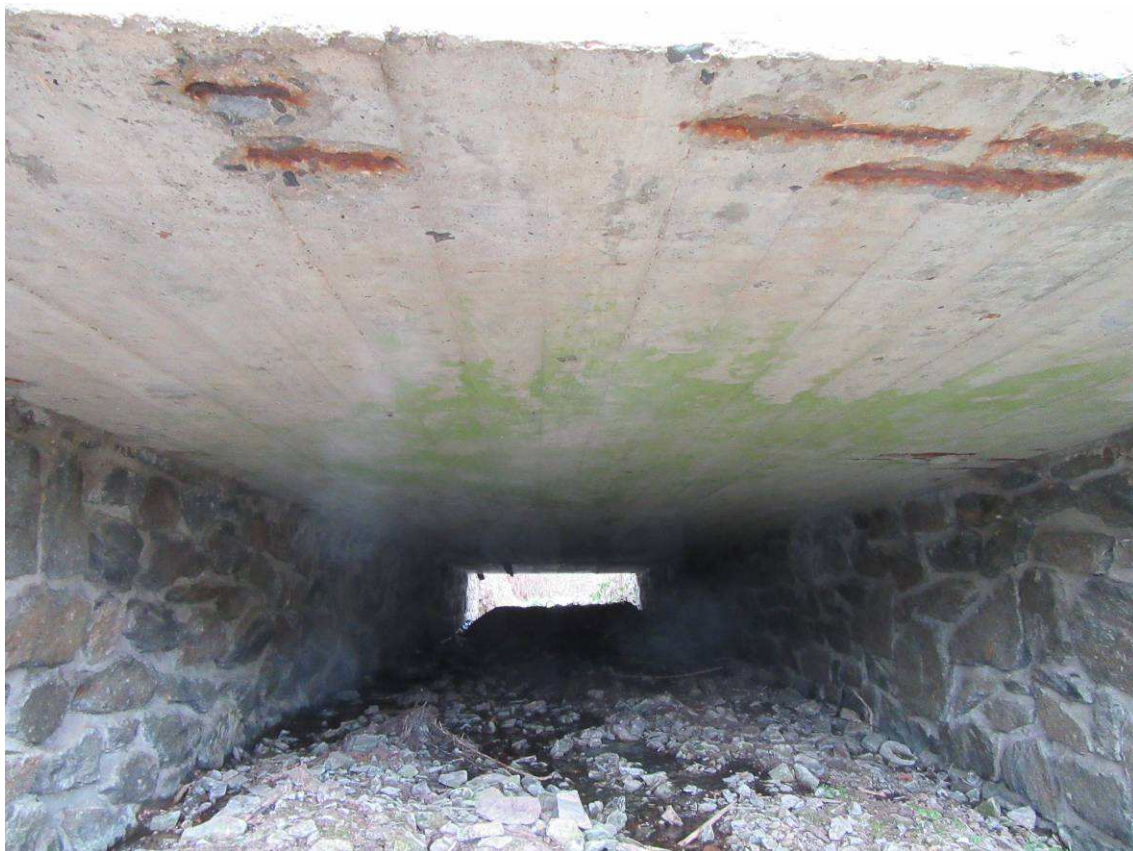
Pohled pod most. Lok. odpadlé krytí + koroze výztuže, biologické napadení, průsaky.
