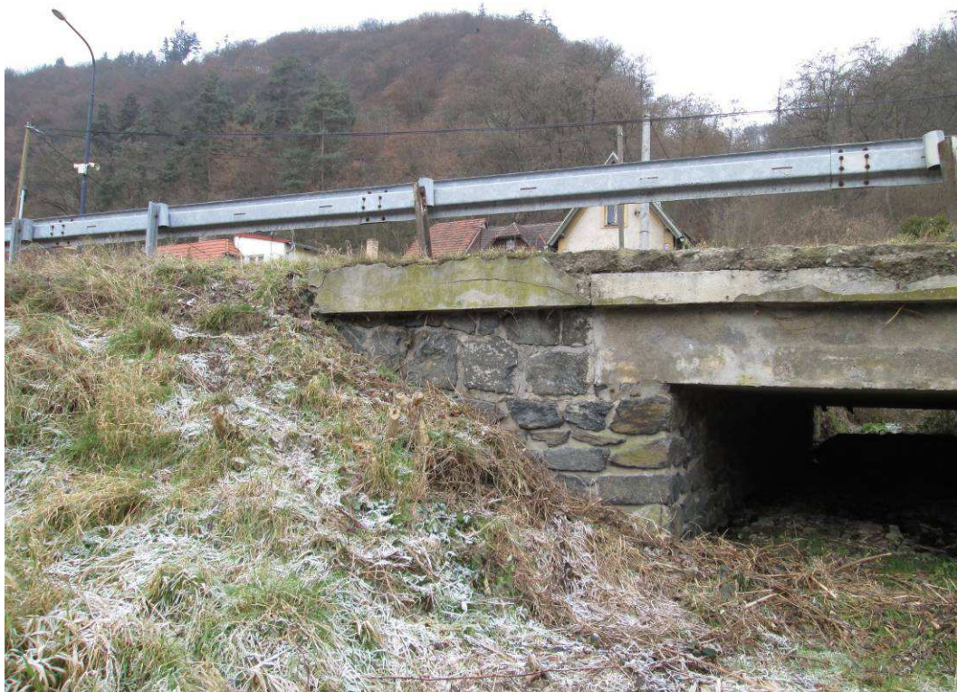
Levý bok NK – trhliny, výluhy. Odpadlý vnější povrch římasy.
